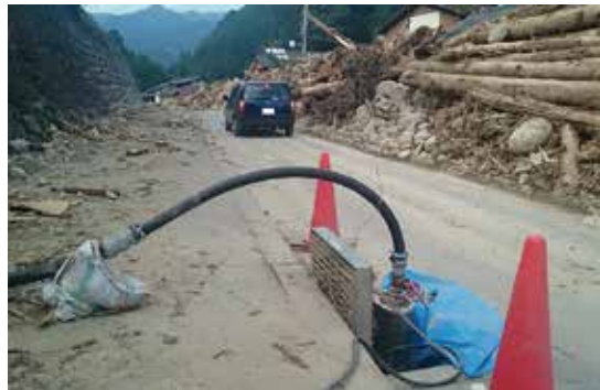
被災地の応急仮設管路をつなぐ
