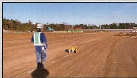
マーキング作業状況
