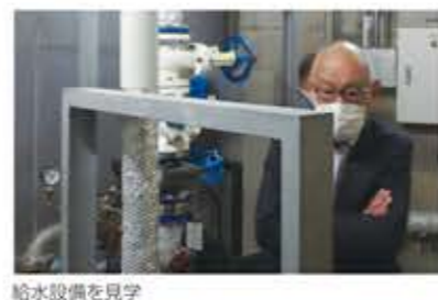
給水設備を見学
