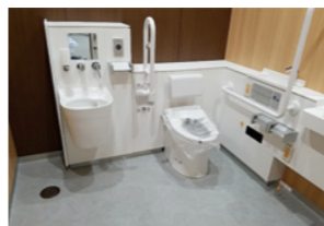
【1階 多目的トイレ】
