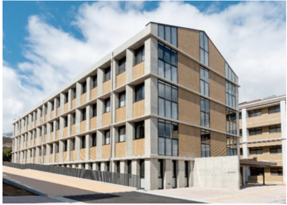
【南東側から見た建物外観】
