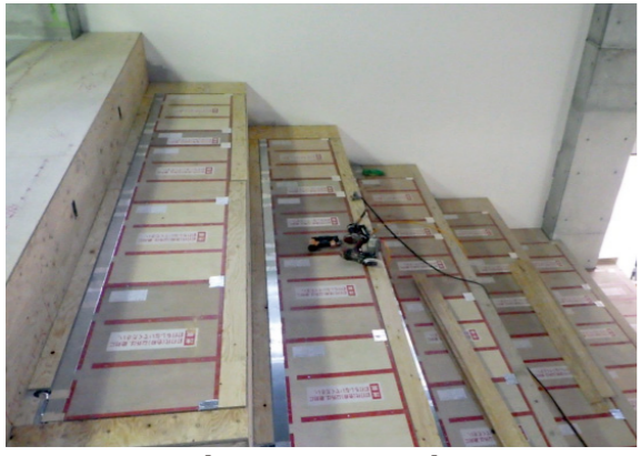
【大階段の床暖房パネル】
