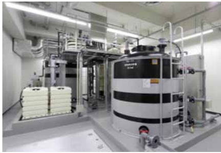
【排水処理設備】
