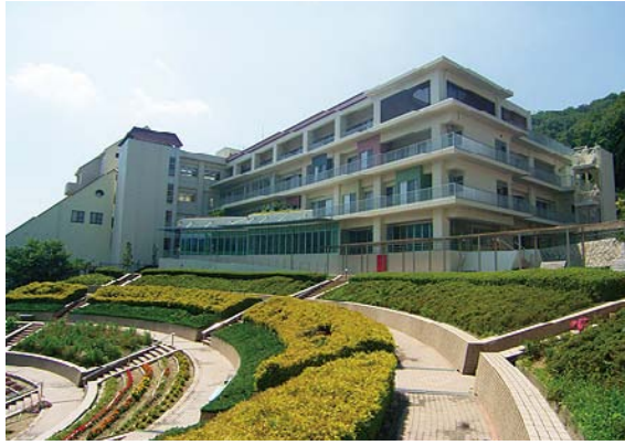
【南東側から見た建物外観】
